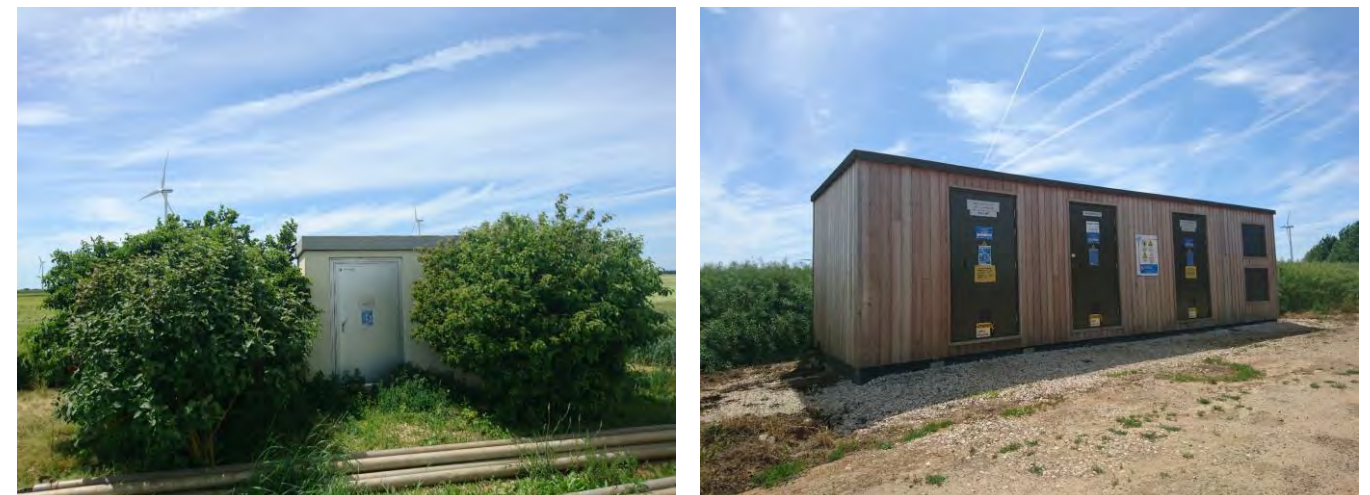
Photographie 77. Les deux types de postes de livraison actuellement en service sur le parc
